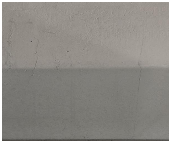
Ф8. Волосяные трещины (шириной раскрытия до 0,2 мм) вдоль поперечной арматуры армирования полок ригелей
