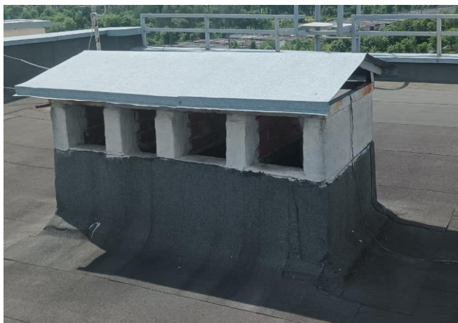
Ф18. Механическое крепление кровли к стенкам вентиляционной шахты в осях 9-19/В-Е отсутствует
