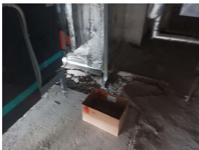
Ф27. Разрушения покрытия пола в месте демонтированного ранее оборудования
