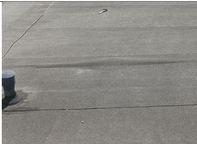
Ф17. Вздутие рулонного ковра кровли в осях 14-15/А-В.
