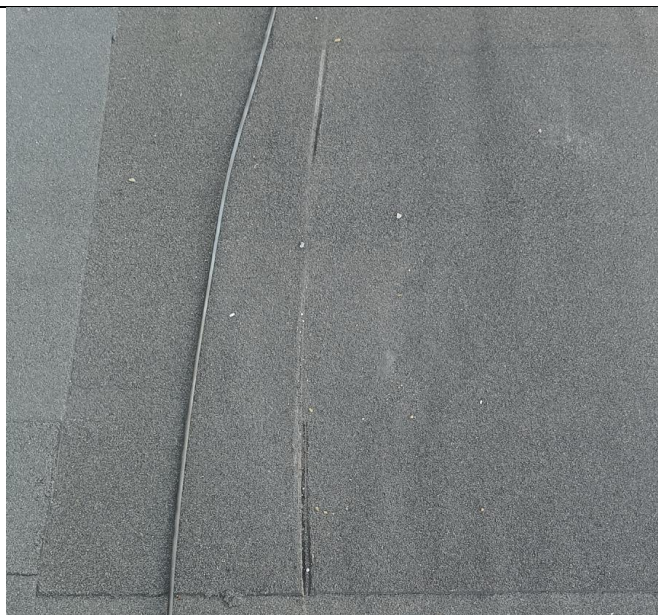
Ф19, Ф20. Повреждение кровли нагрева металлической сетки солнечным излучением.
